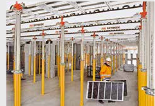
Encofrados para losas
