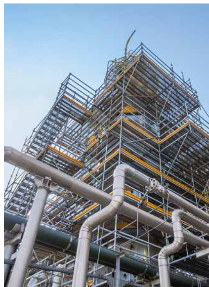
Las torres de escaleras con unidades de escalera en la misma dirección tienen la ventaja de que, además de las unidades de escalera, se dispone también de plataformas de trabajo.
