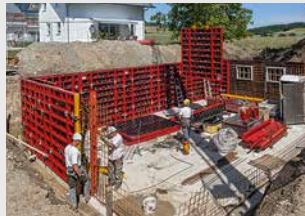
Encofrados para muros
