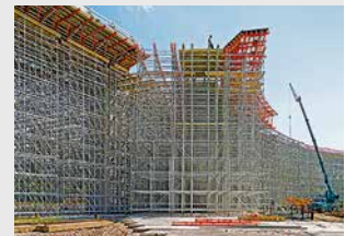
Cimbras y torres de carga
