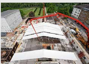
Andamios de protección
