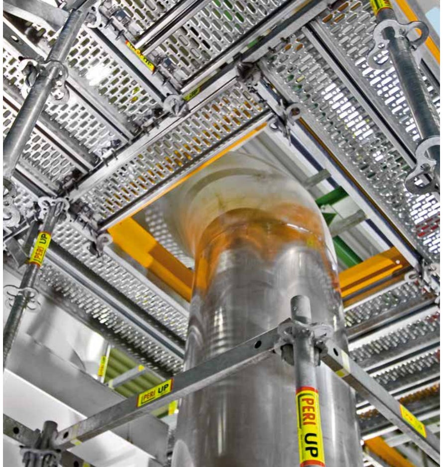
El cambio de orientación de las plataformas con la modulación de 25 cm proporciona un gran nivel de adaptabilidad, sin necesidad de acopladores tubulares.
