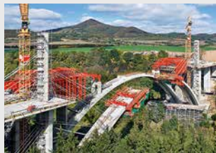
Encofrados para puentes
