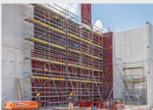
Andamios de trabajo para la construcción
