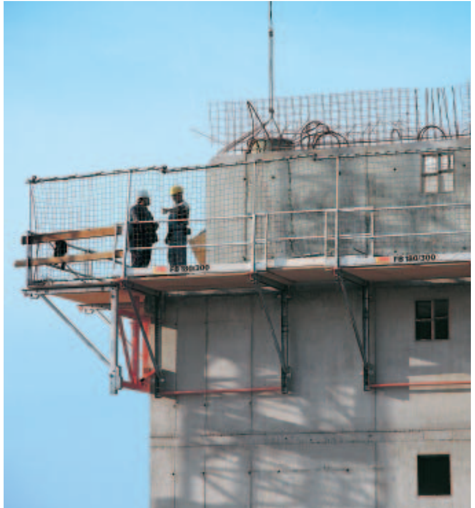
Plataforma plegable FB 180-3 con red de protección utilizada como contención.
