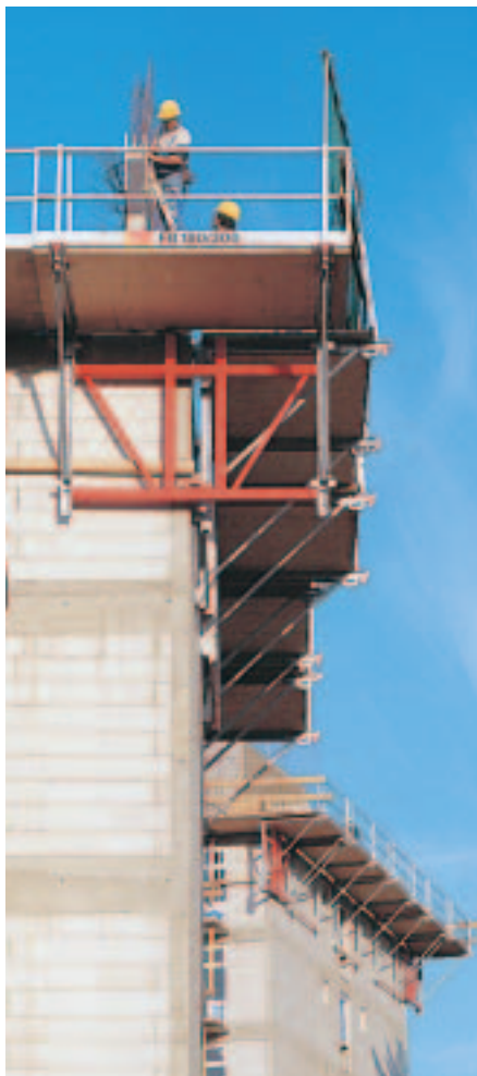
Uso como plataforma plegable de esquina derecha.
