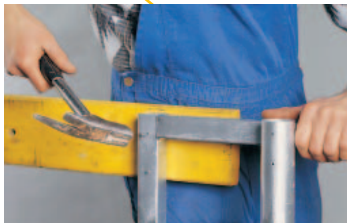
Los taladros para clavos en la barandilla permiten colocar fácilmente las tablas de contención.
