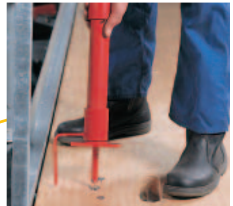
El poste frontal de barandilla FBP para colocar las tablas de contención provistas por la obra se introduce girando en la fijación multifuncional (DW 15).
