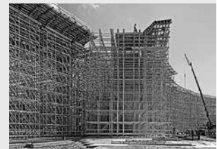
Cimbras y torres de carga
