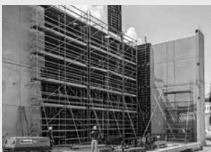
Andamios de trabajo para la construcción
