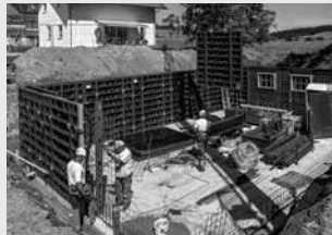
Encofrados para muros
