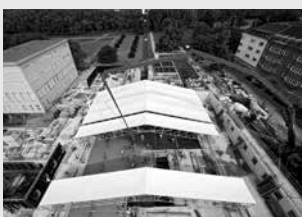
Andamios de protección
