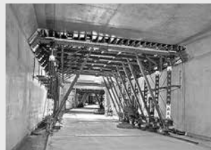
Encofrados para túneles
