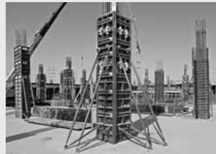
Encofrados para pilares y columnas circulares
