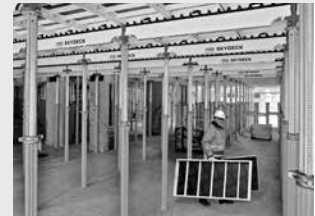
Encofrados para losas
