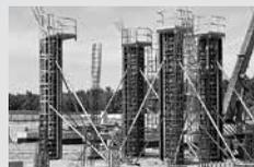
Encofrados para pilares y columnas circulares
