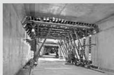
Encofrados para túneles
