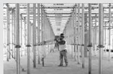
Encofrados para losas
