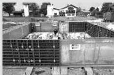
Encofrados para muros
