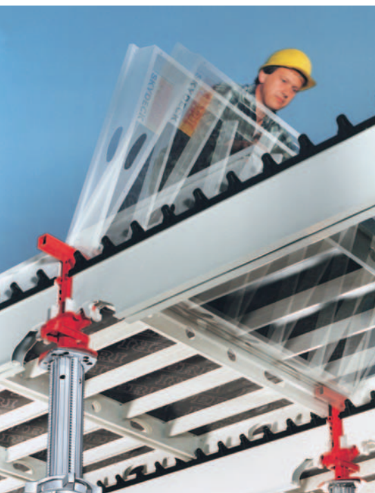
Encofrado con paneles SKYDECK desde arriba.
