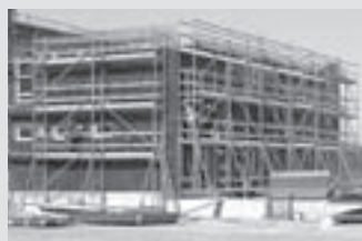
Andamios de trabajo para la construcción
