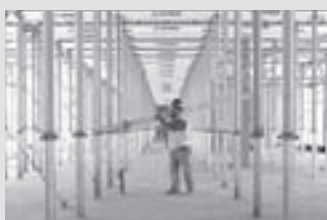
Encofrados para losas
