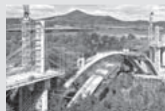
Encofrados para puentes
