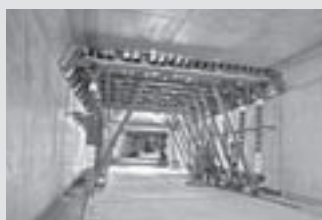
Encofrados para túneles
