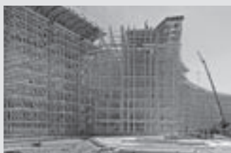
Cimbras y torres de carga
