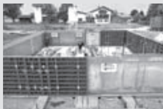
Encofrados para muros
